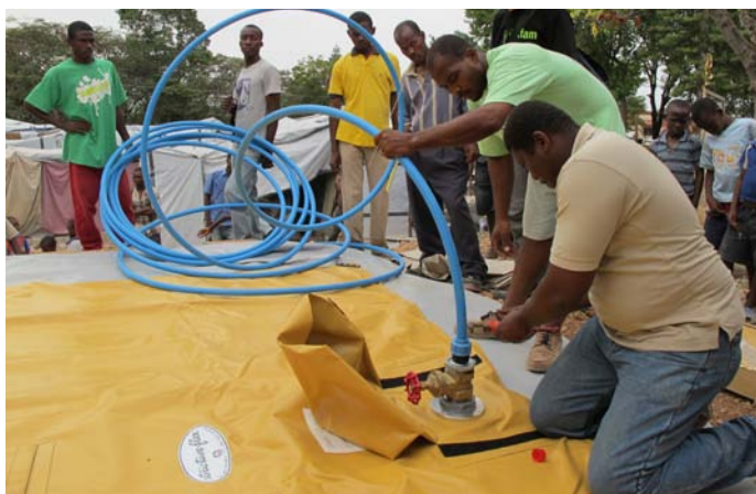
Das Trinkwasser für die Camps in Haiti wird größtenteils mit Tankwagen angeliefert und in mobilen „Wasserkissen“ gespeichert. © Justine Lesage/Oxfam Quebec
