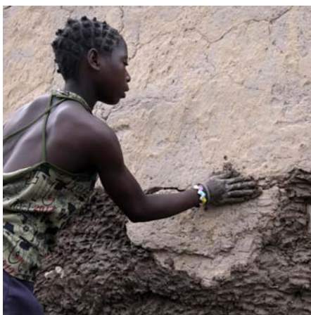
Sakubita M. repariert das Haus ihrer Familie in West-Sambia, das durch Fluten beschädigt wurde. © James Oatway/Oxfam
