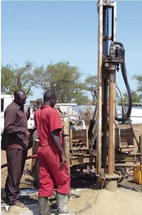
Oxfam-Mitarbeiter bohren im südsudanesischen Camp Gendrassa einen neuen Brunnen. In der kargen Region ist es schwierig, Wasser zu finden. © Markus Nitschke / Oxfam Deutschland
