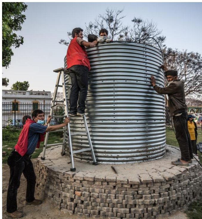
Oxfam-Mitarbeiter und Freiwillige errichten einen 11.000-Liter-Wassertank im Tundikhel-Camp, wo Oxfam insgesamt 15.000 Menschen mit Wasser unterstützt. Foto: Pablo Tosco / Oxfam
